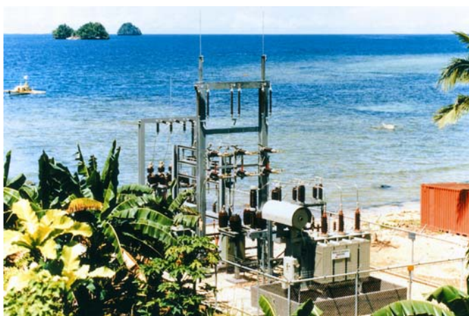
Береговая подстанция на 34,5 кВ Минданао, Филиппины
