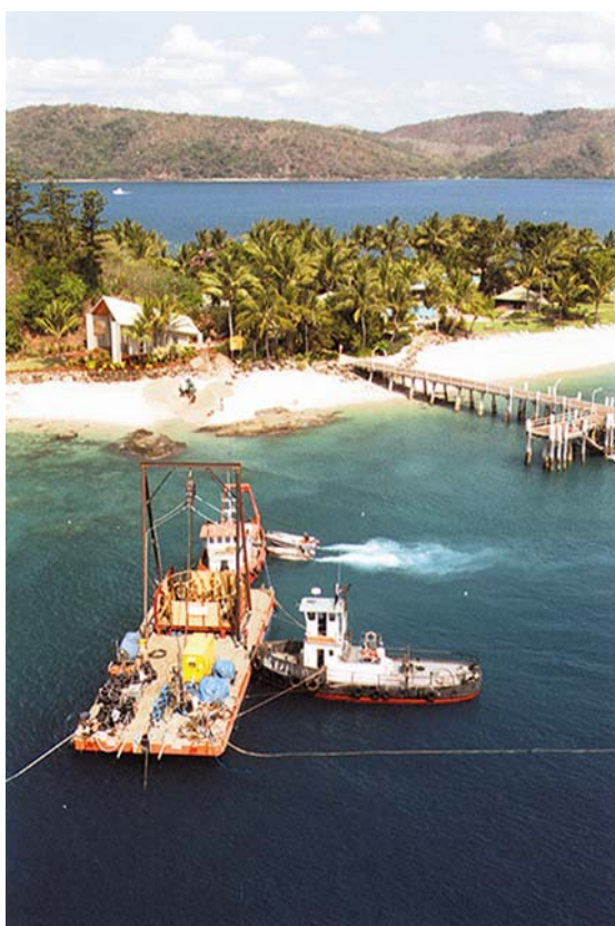
Прокладка подводного кабеля у берега австралийского острова
