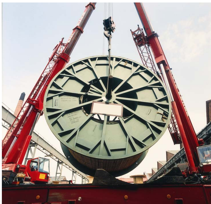
Подъем барабана с подводным силовым кабелем для Абу-Даби
