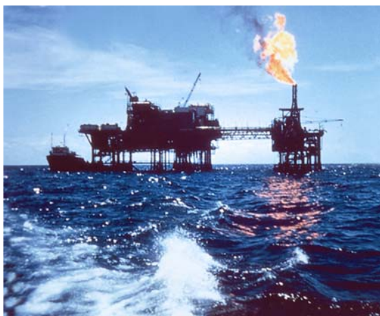
Морская нефтяная платформа в Индонезии, электроснабжение по подводному кабелю
