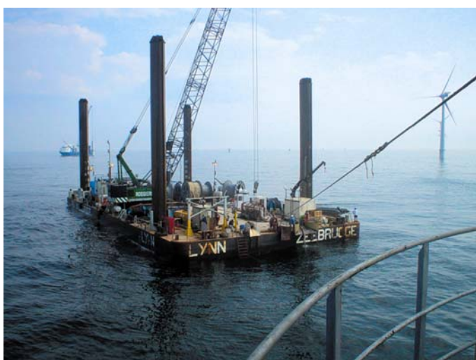
Прокладка кабелей для морского ветряного парка Хорнс Рев, Дания
