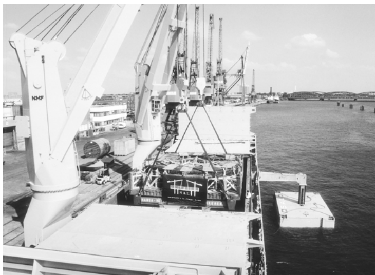
Погрузка контейнера с силовым кабелем для подводной прокладки весом 300 тонн для КНДР
